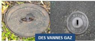
DES VANNES GAZ
