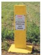
UNE BORNE TIGF transport et infrastructure gaz de France
